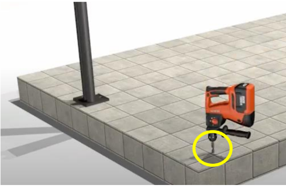
Placer stolper iht. tegning, forbor hullerne og fastgør stolperne.
